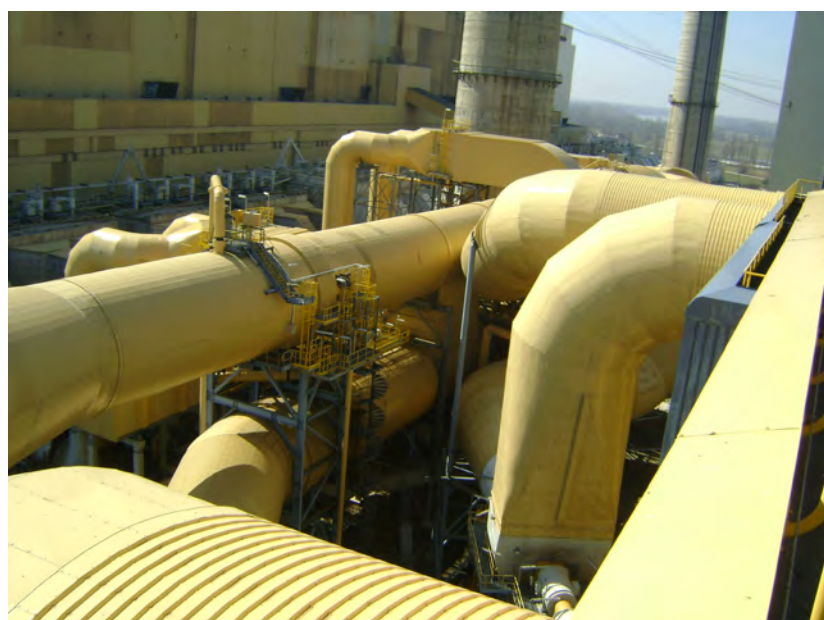
Fot. 2. Realizacja II etapu IOS
