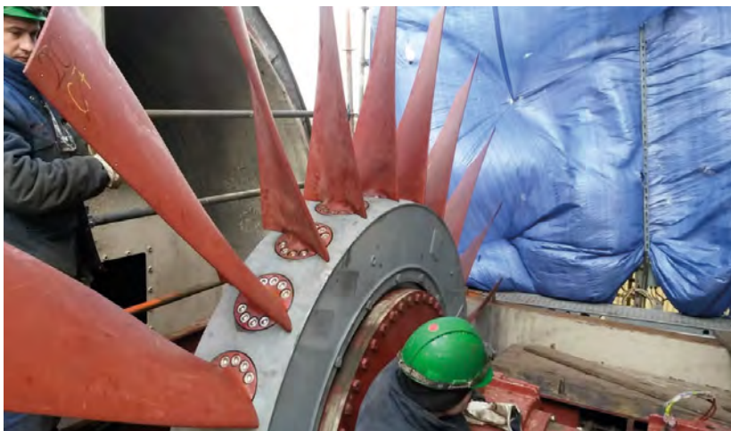
Fot. 8. Wymiana układu wirującego
