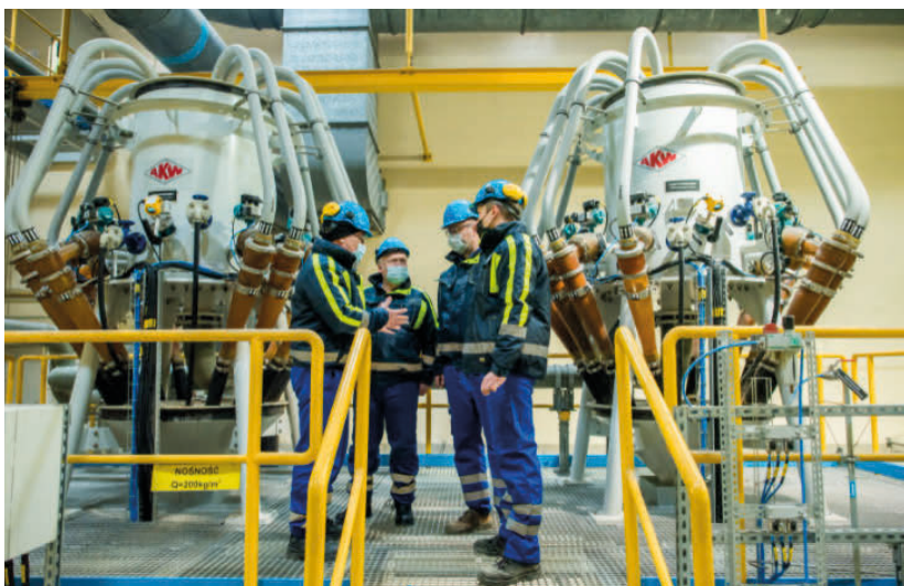
Fot. 10. Hydrocyklony gipsu
