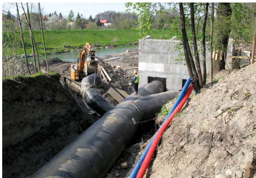
Budowa rurociągów derywacyjnych dla małej elektrowni wodnej na rzece Olzie
