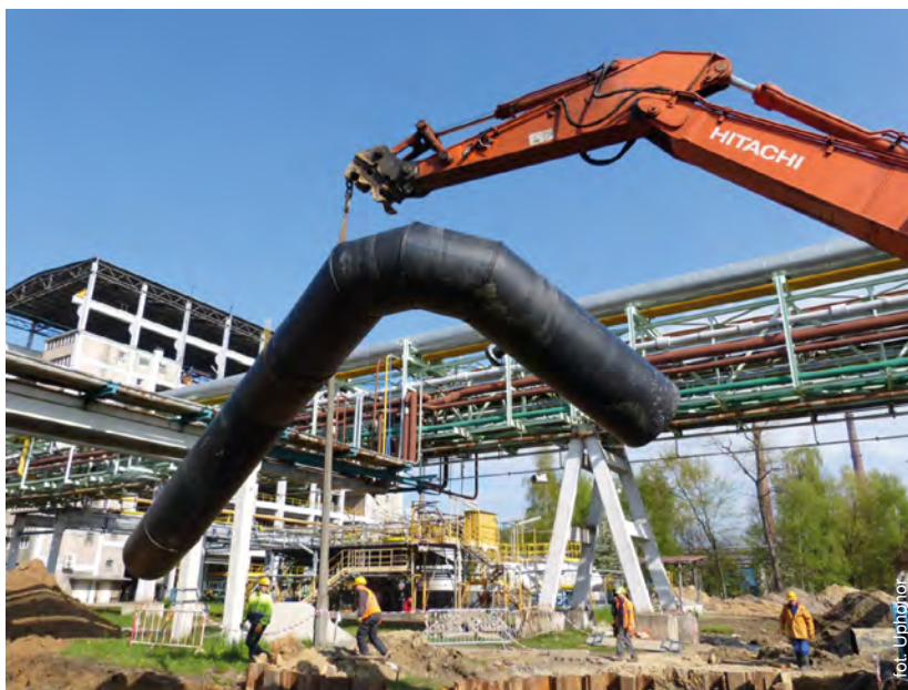
Wymiana stalowych rurociągów wody obiegowej dla Synthos S.A.
