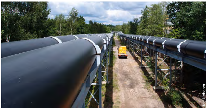
Transport odpadów połotacyjnych na składowisko Żelazny Most
