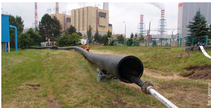
Budowa rurociągów wody surowej dla Elektrowni Kozienice – przewiert horyzontalny HDD
