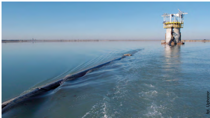
Rurociąg pływający na składowisku Żelazny Most - transport wód nadosadowych
