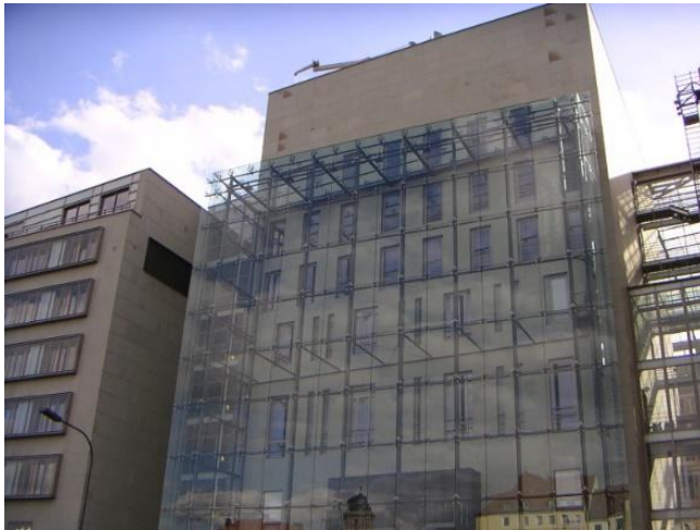
Rysunek 6. Struktura szklarniowa pełniąca rolę termobuforową: ściana północna budynku, Berlin. Fot. J. Biedrońska
