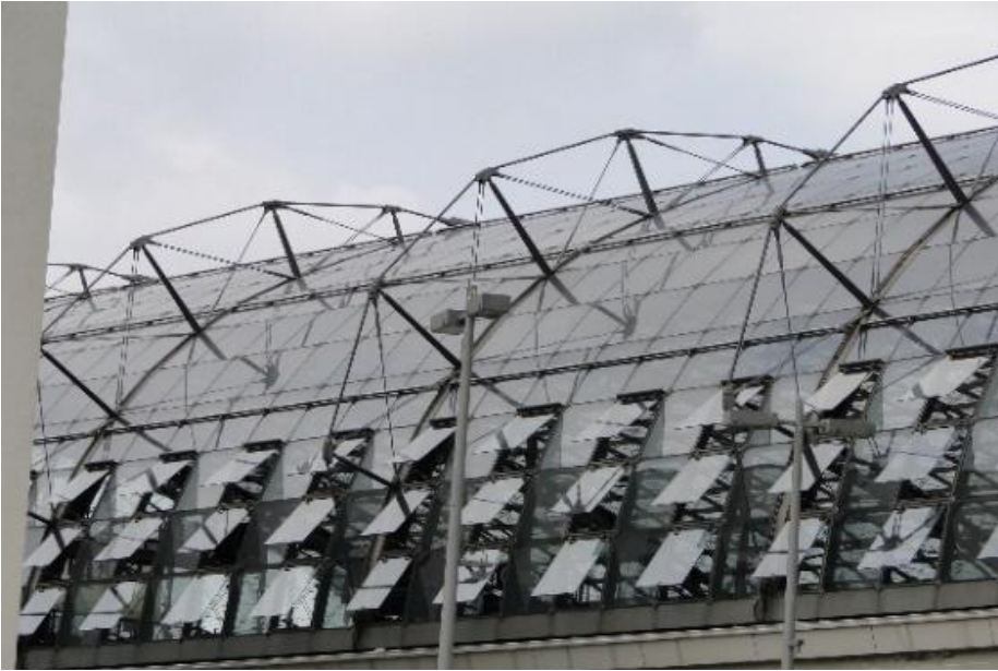
Rysunek 5. Przeszklona struktura dachowa dworca w Berlinie. Fot. J. Biedrońska
