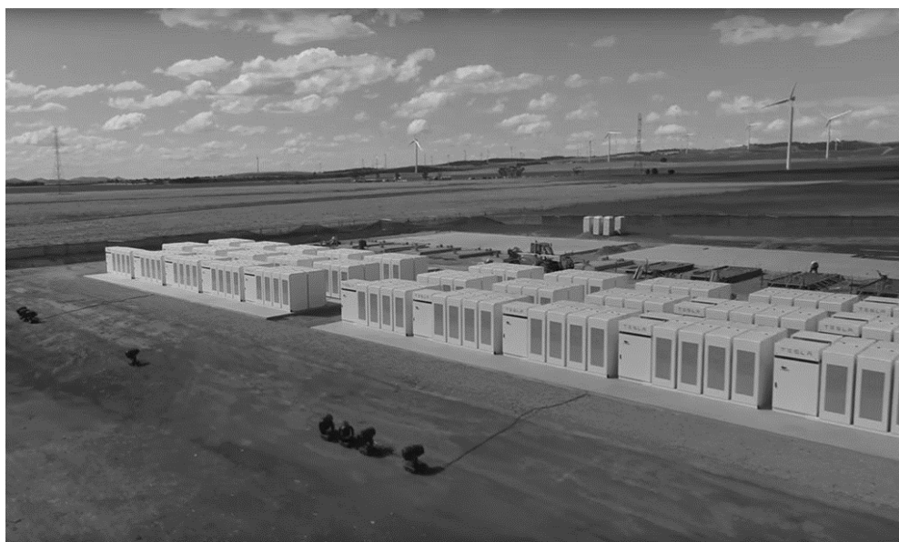
Rysunek 14. Projekt Elana Muska w Australii, zrealizowany w 100 dni – magazyn 29 MWh energii w akumulatorach Tesli dla zdecentralizowanego (off the grid) zaopatrzenia w energię elektryczną 30 tysięcy gospodarstw domowych przez 3 dni [87].
