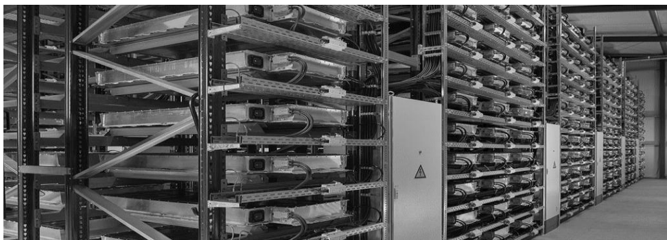
Rys. 13. Projekt BMW w Lipsku – zmagazynowanie 66 MWh (energii wystarczającej dla 15 000 gospodarstw domowych przez 3 dni) przy użyciu 700 częściowo (w 16%) wyeksploatowanych akumulatorów BMW i3 o pojemności 94 kWh [88].
