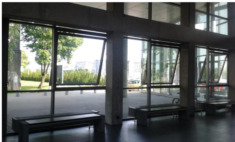
Rysunek 11. System otwieranych okien w dolnej partii budynku w Centrum Nowych Technologii przy Politechnice Śląskiej w Gliwicach. Fot. J. Biedrońska
