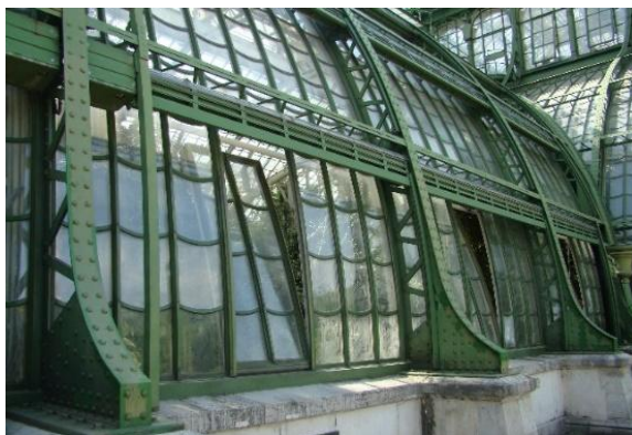
Rysunek 8. Naturalny sposób wentylacji otwieranych okien Palmiarni w Schönbrunn Wiedeń. Fot. J. Biedrońska
