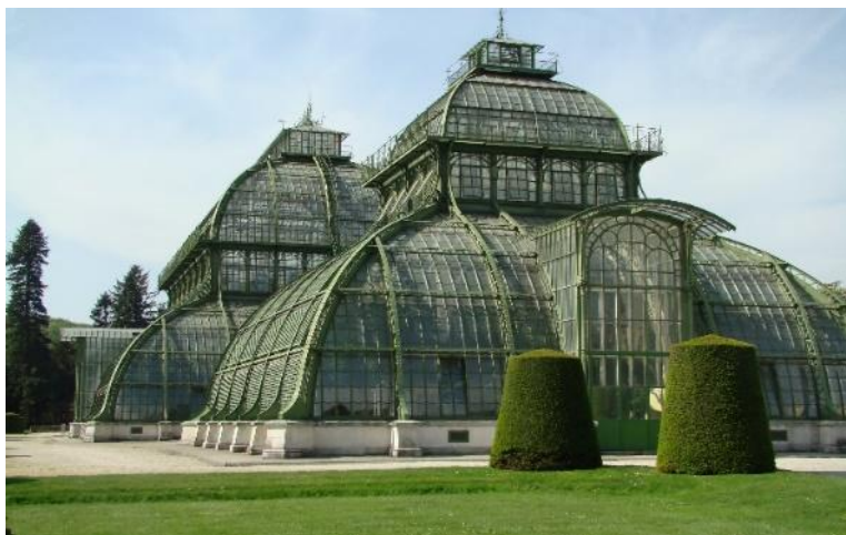
Rysunek 1. Palmiarnia w Schönbrunn Wiedeń, Austria, (rok powstania 1882). Konstrukcja żeliwna. Fot. J. Biedrońska
