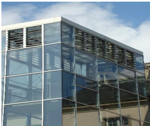
Rysunek 7. Struktura szklamiowa pełniąca rolę termobuforową: wertykalna obudowa klatki schodowej, Drezno. Fot. J. Biedrońska
